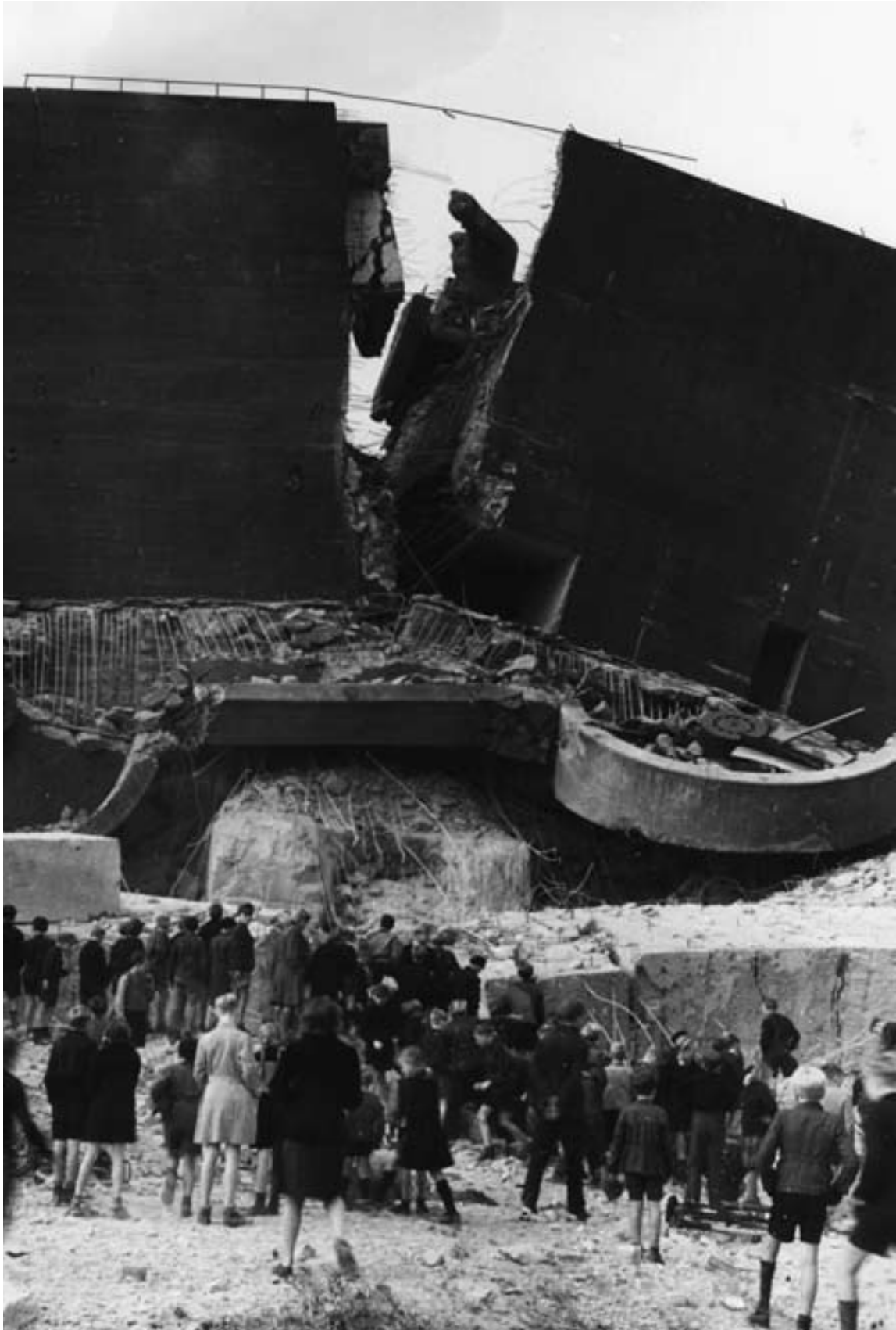
Sprengung des kleinen Wilhelmsburger Flakbunkers im Oktober 1947
