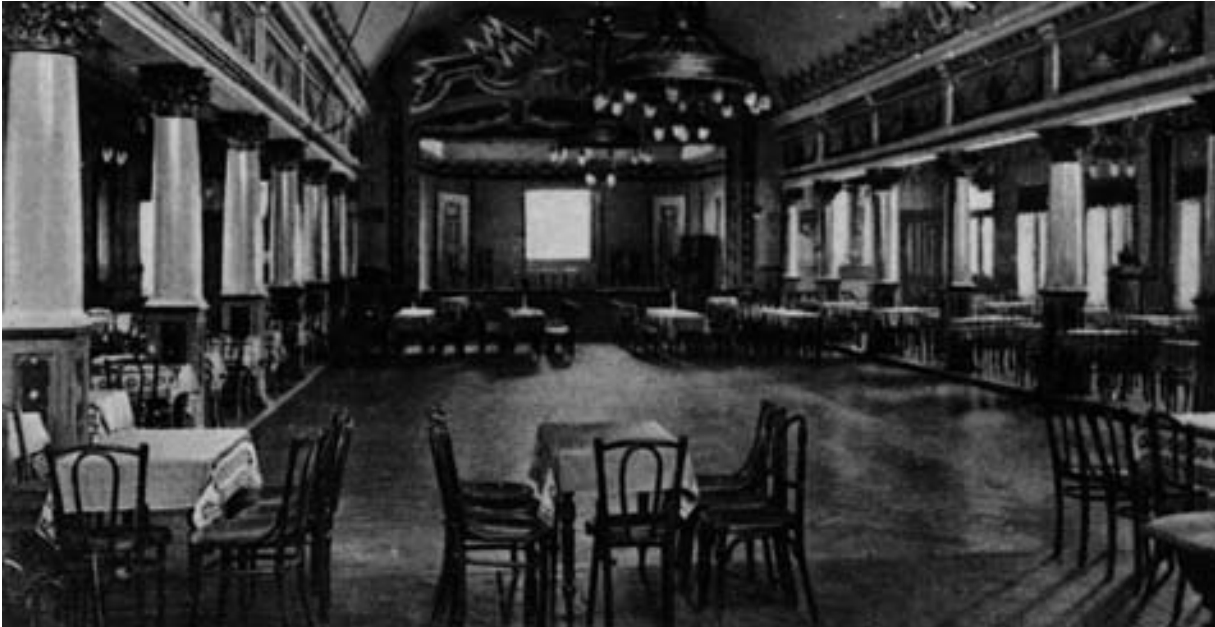
Stübens Saal, 1882 erbaut, war einer der kulturellen Mittelpunkte des Reiherstiegviertels
